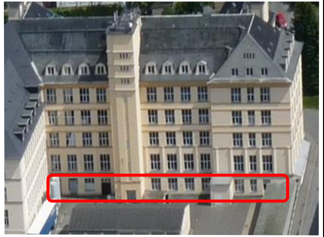
Kellergeschoß, welches entkernt wurde
