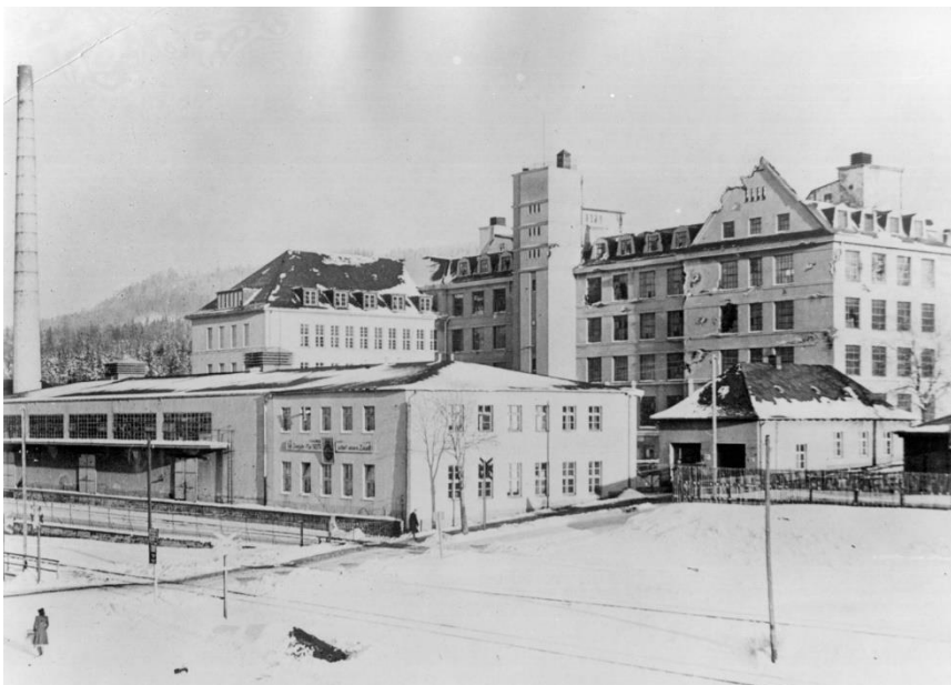
Der Betrieb wurde noch im Winter 1945 von Brandbomben getroffen.
